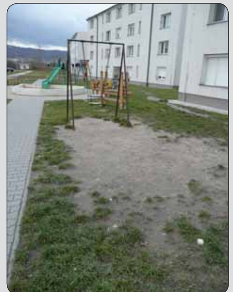
Slabo udržiavané verejné detské ihrisko s nezatrávnenými plochami v blízkosti chemických závodov ISTROCHEM, ide o problém kontaminácie nezatrávnených plôch a ich kontakt s hrajúcimi sa deťmi
