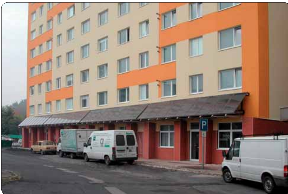
Solárny systém na predohrev ohriatej pitnej vody na sídlisku Hliny v Žiline (foto: Thermo | solar Žiar)
