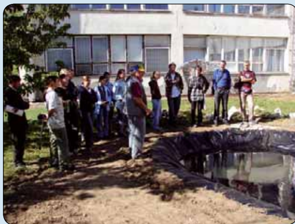
Realizácia oddychovej zóny pri ZŠ v obci Ždaňa
