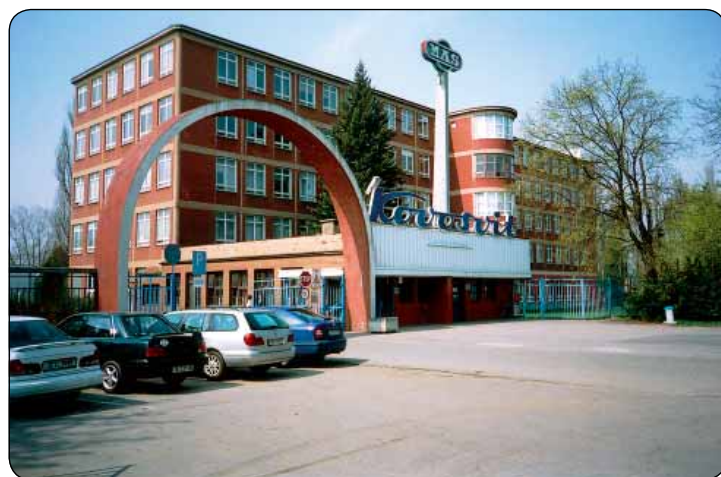
Sezimovo Ústí, ČR: pôvodný vstupný areál do strojárkeho závodu. Autor oblúku vjazdu: J. Gočár. V pozadí 5-etážová polyfunkčná budova
