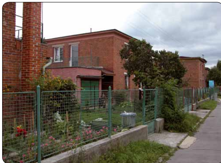
Partizánske: obytné domy z charakteristického červeného rezného muríva. Ploty z kovu vymenili živé ploty. Objavujú sa rozličné prístavby, predovšetkým garáže
