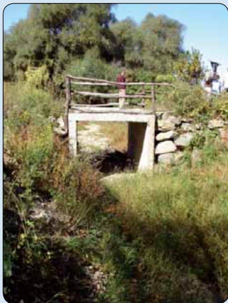
Sprietochenie mŕtveho ramena pri vyšších stavoch Hornádu
