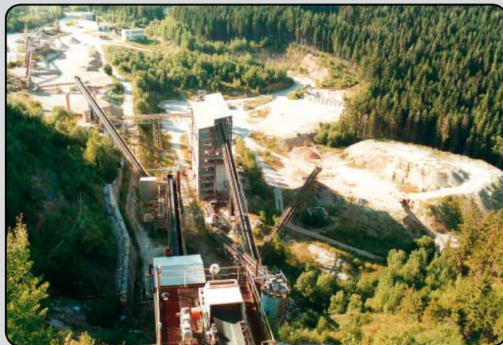
Lom na vápenc Greta pri Novoveskej Hute (technologické zariadenie a manipulačné plochy)
