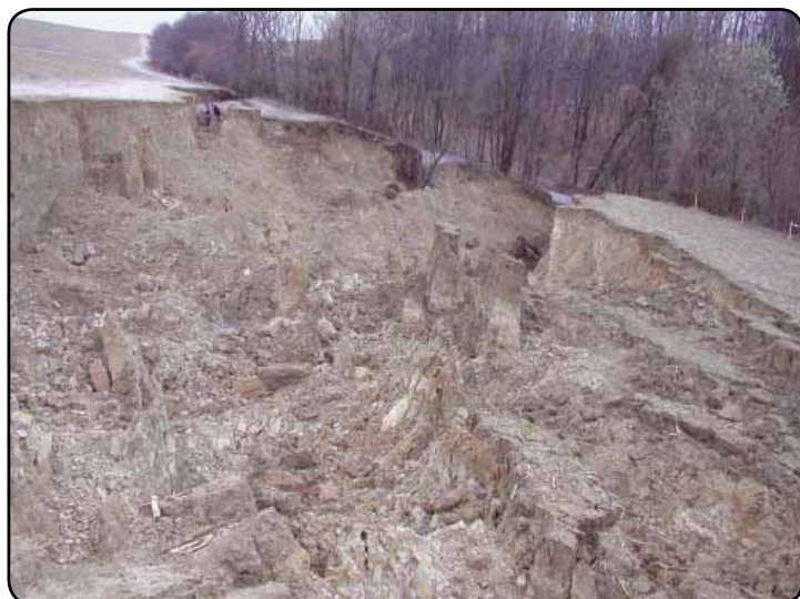
Obr. 3: Detail širokej odľučnej oblasti zosuvu
