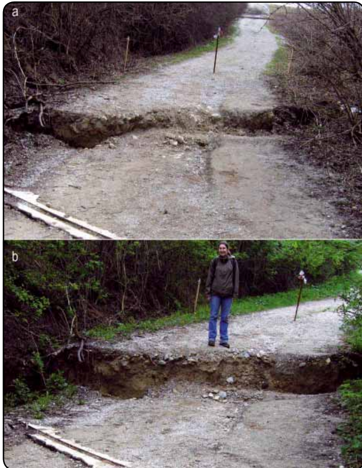
Obr. 5 – Vývoj porušenia cesty zaznamenaný v dňoch 12. 4. 2006 (a) a 4. 5. 2006 (b). Z porovnania vyplýva pokračujúci pokles cesty o cca 20 až 30 cm v priebehu 3 týždňov
