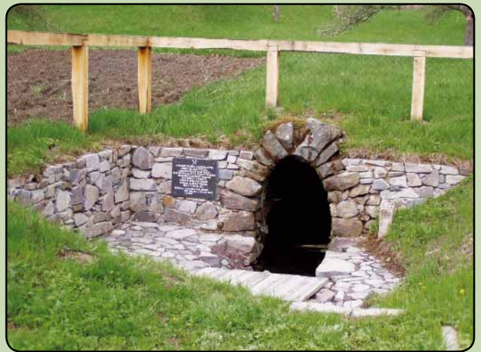
Zrekonštruovaný portál dedičnej štôlne Bieber
