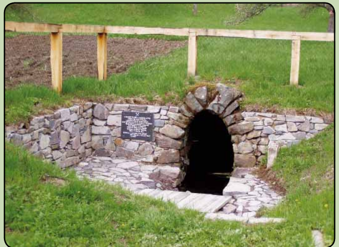
Zrekonštruovaný portál dedičnej štôlne Bieber
