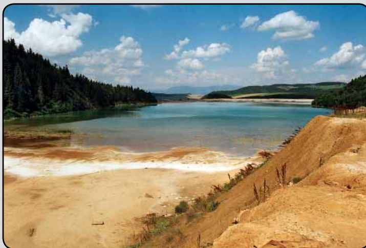
Rudňany - odkalisko, pohľad od zadnej hrádze
