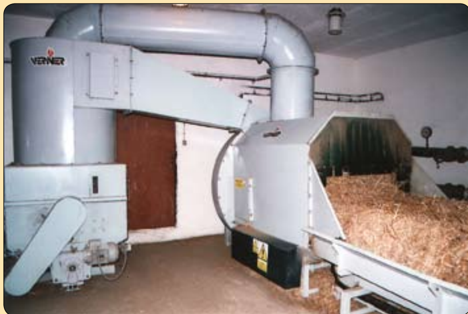
Časť kotolne na spaľovanie slamy na sídlisku v Turni nad Bodvou (foto: Ján Lichý)
