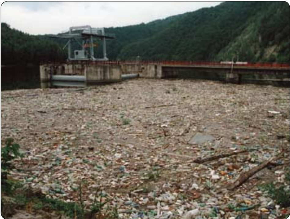
Plávajúci odpad na hladine nádrže VD Ružin je zachytený plávajúcou stenou v priestore objektov priehrady. Odpad pochádza z obcí s okolitými riekami Hnilca a Hornádu (foto: Ján Lichý)
