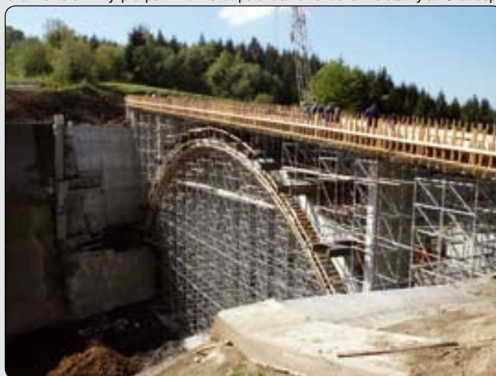
Výstavbe mostu na Kysuciach predchádzala EIA
