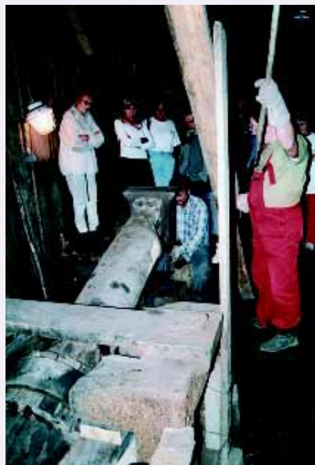
Kováč kuje a pomocník usmerňuje tyčou prívod vody na koleso, a tým reguluje rýchlosť úderov kladiva (bucharu)
