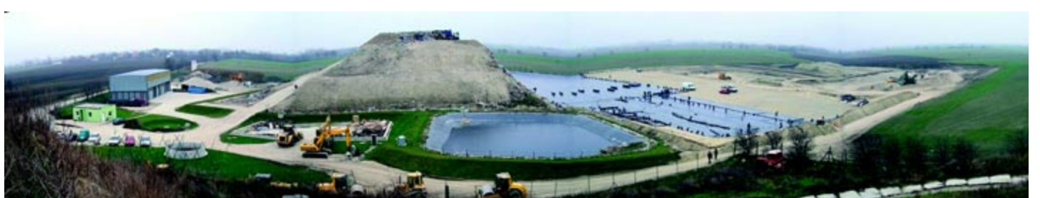
Celkový pohľad na skládku odpadov - vľavo sú prevádzkové objekty, v strede prevádzkovaná I. etapa, vpravo pripravovaná II. etapa, v popredí akumulácia nádrž priesakových kvapalín
