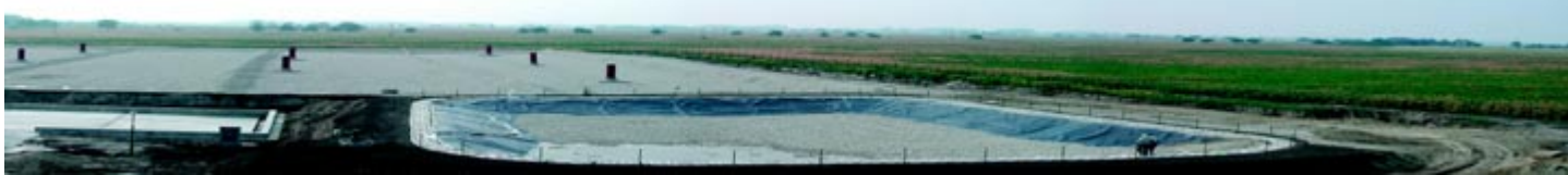
Panoramatický pohľad na budovanie skládky odpadov v prvej etape
