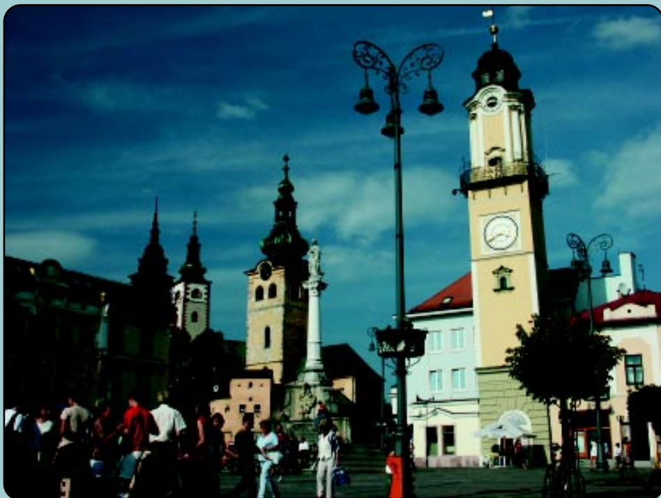
Hlavnému banskobystrickému námestiu v hornej časti dominuje do strany naklonená Hodinová veža. Jej záchrana si vyžiadala betónovú injekciu v základoch a odklonenie dopravy (foto: T. Kopečný)
