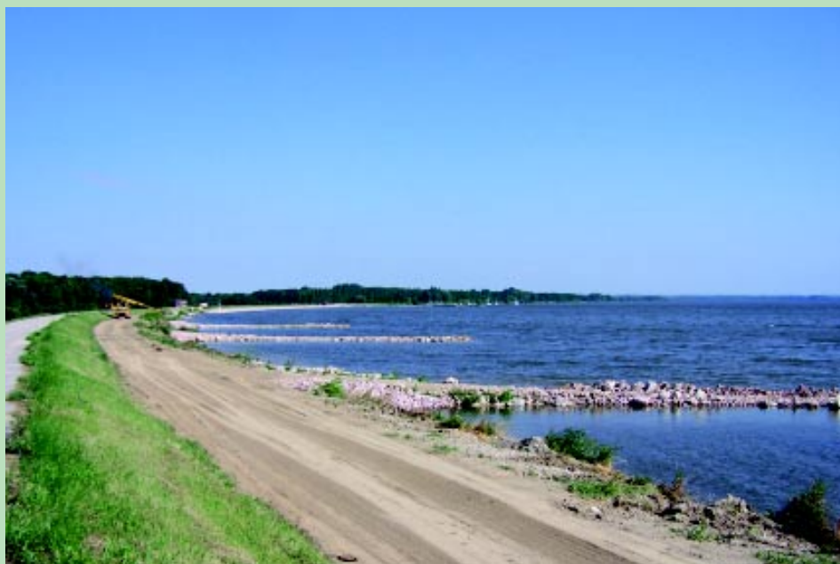
VD Kráľová - stabilizácia pravostrannej ochrannej hrádze
