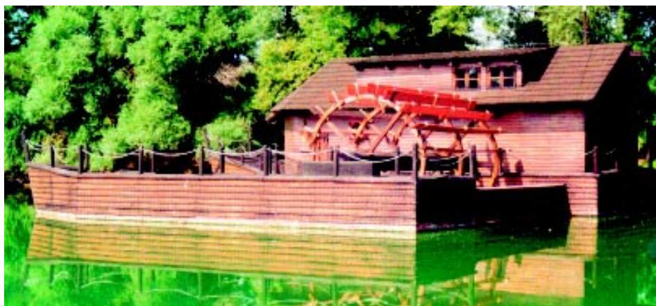
Rekonštrukcia lodného mlyna v Radvani nad Dunajom (realizácia ukončená v roku 1983, autori projektu: Krivošová, J. Lichardová, V., Samová, M.)
