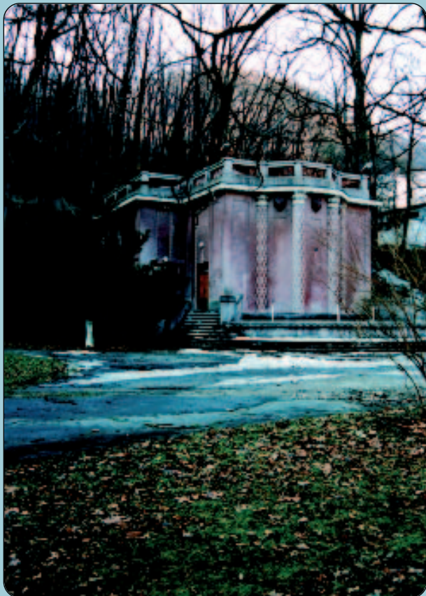
Budova bývalej MVE Trenčianske Teplice
