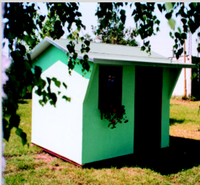
Záhradný domček obložený stavebnými doskami z tetrapaku
